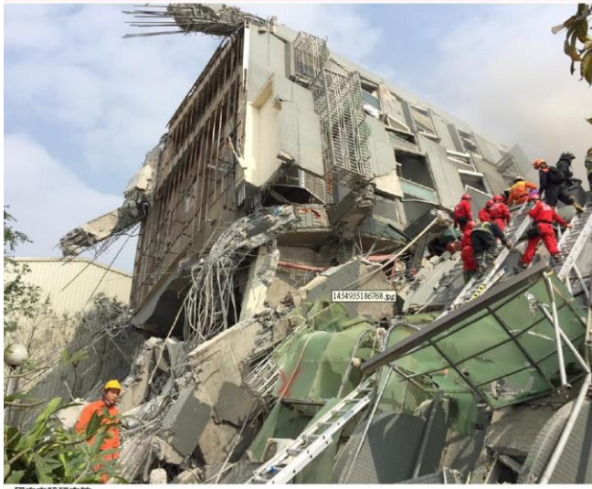
(1)永康區維冠金龍大樓倒塌現況
